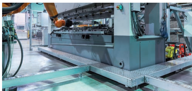
Obr. 4 Pochôdzne káblové žľaby BKRS 100/110 na robotizovanom pracovisku
