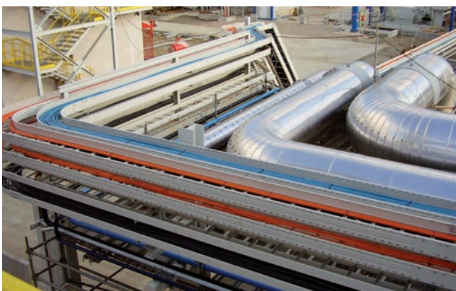
Obr. 2 Káblové rebričky LG 110 a WKLG 160 na káblovom moste chemickej rafinérie
