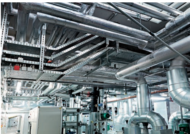
Obr. 1 Káblové žľaby MKS 60 v kombinovanom energetickom centre
