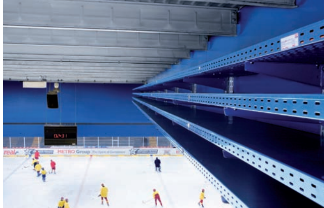
Obr. 6 Káblové žľaby RKSM 60 s lakom pod stropom športovej haly
