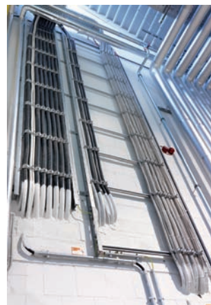
Obr. 3 Priemyselné zvislé káblové rebričky SLS 80
